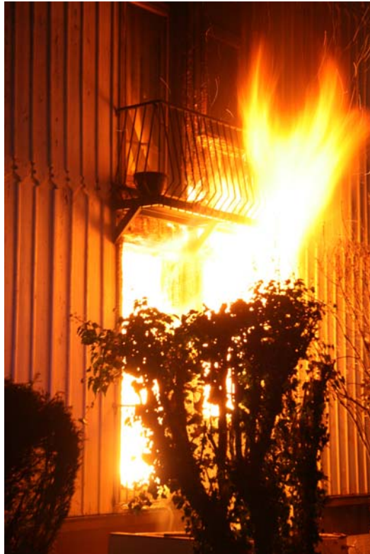
17:13 Uhr: Situation nach dem Eintreffen der ersten Kräfte. Deutlich sichtbar der Flammüberschlag ins darüber liegende Geschoss. Foto (GZ).
