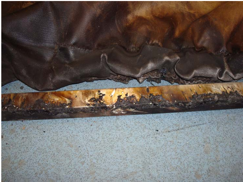
Detailaufnahme vom Rauchverschluss
