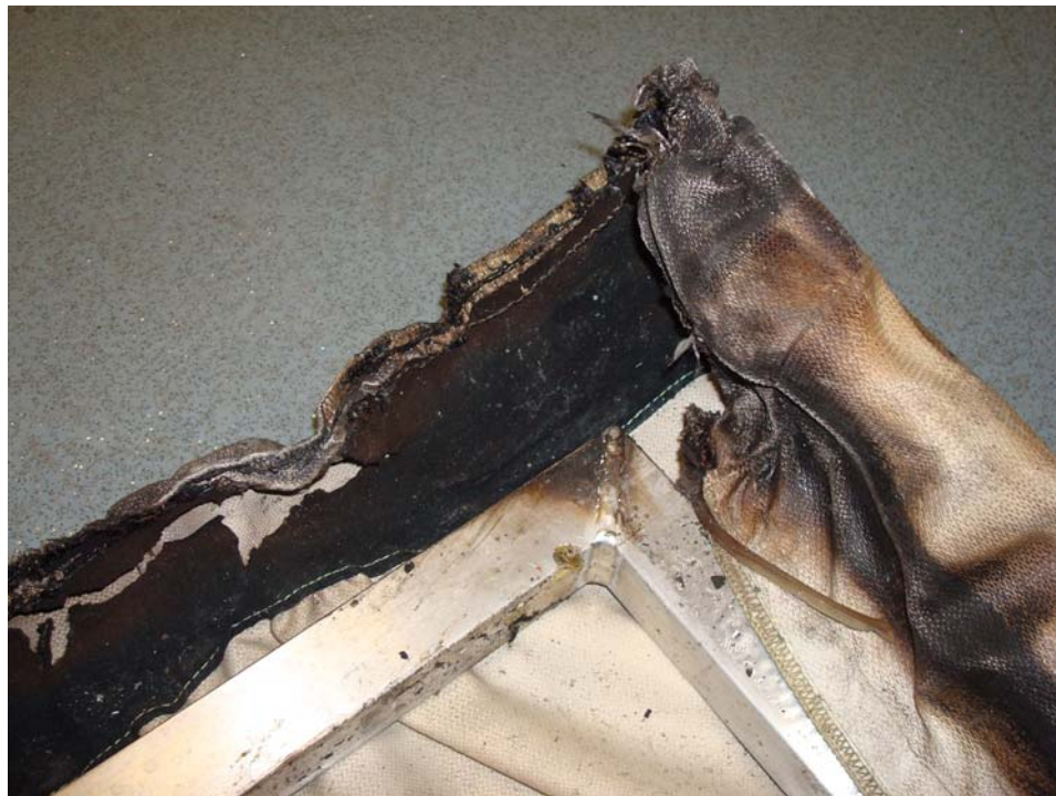
Detailaufnahme vom Rauchverschluss
