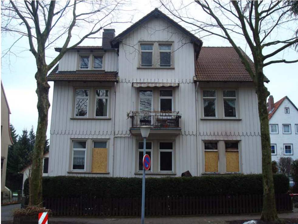
Das Gebäude am Tag nach dem Brand. Die unteren Fenster wurden durch eine Fachfirma gesichert. Oben links die beiden Fenster gehören zum Kinderzimmer, in denen die beiden Kinder angetroffen wurden. (Foto: Einsatzdokumentation FF Bad Harzburg).
